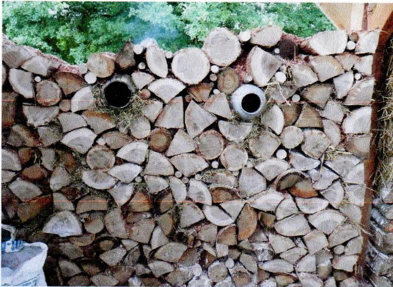
Il a été nécessaire de monter un soubassement en bois d'environ 20 cm pour remplir complètement les murs.
